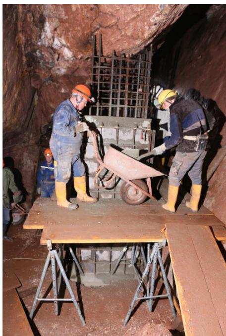
Bewehrung, Schalung sowie das Füllen mit Beton und die fertige Stahlbetonstütze. (Stand: Nov. 2015)
